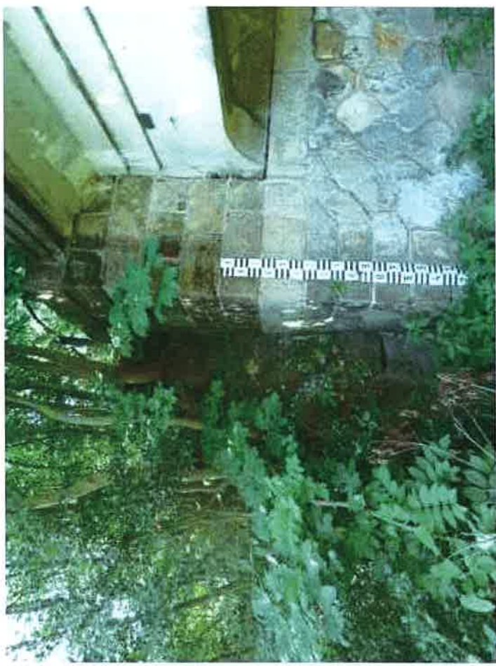
16 venetace u křídla vlevo na vtoku.JPG
