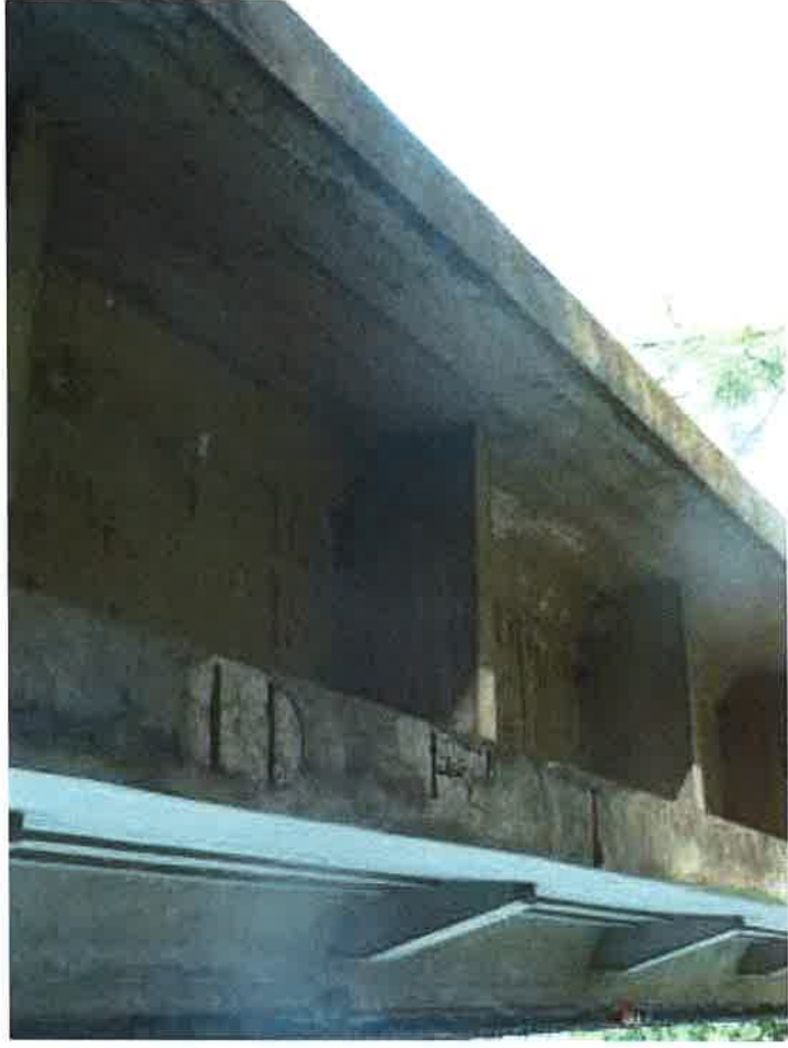
4 nahléd nosné konstrukce v poli vlevo .JPG
